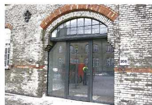
Nyt indgangsparti til mødelokaler og administration i den tidligere staldbygning.
