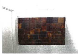
Et lille felt i ydervæggen afslører staldbygningens oprindelige væglade.
