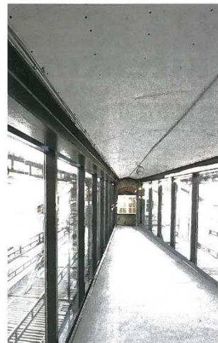
Der pågår endnu noget arbejde på broen.
